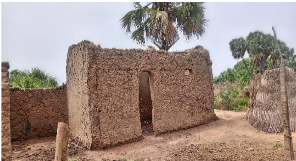
Photo 11 : Aperçu d'un abris à Ouloumssa
