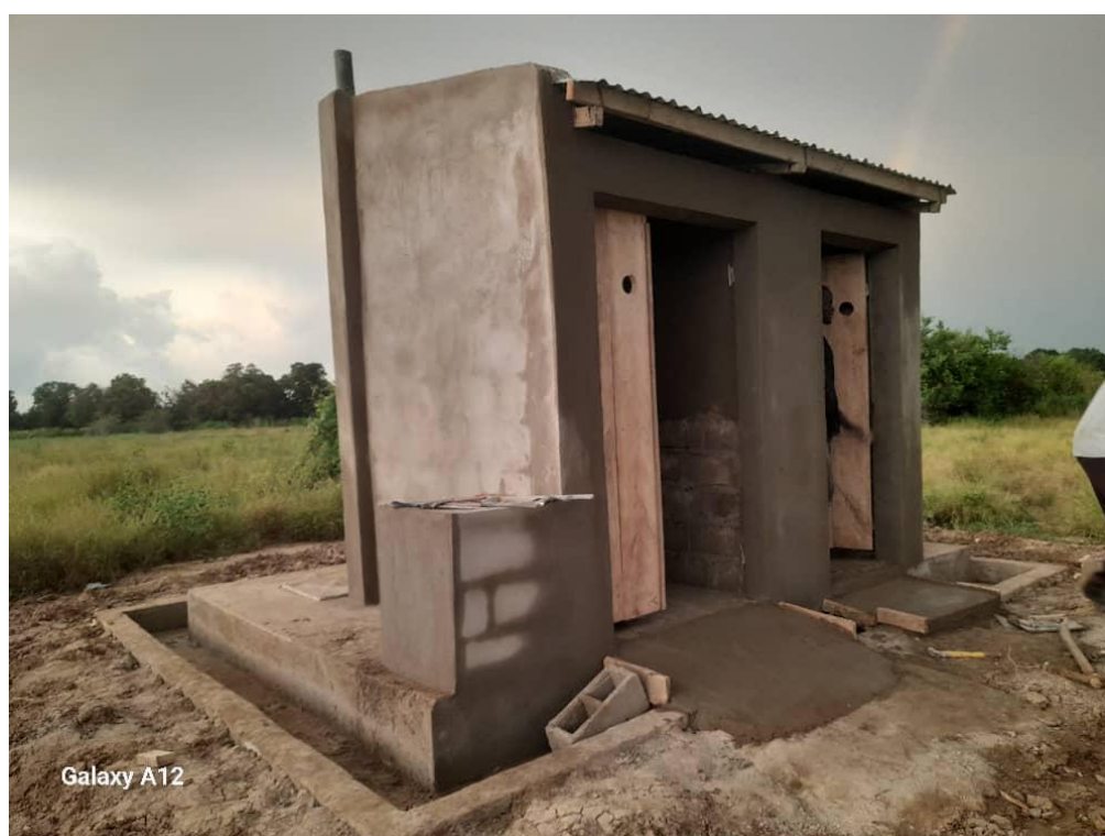
Photo 24: Latrines en cours de construction à Kabella et Bourgouma (Commune de Logone Birni)
