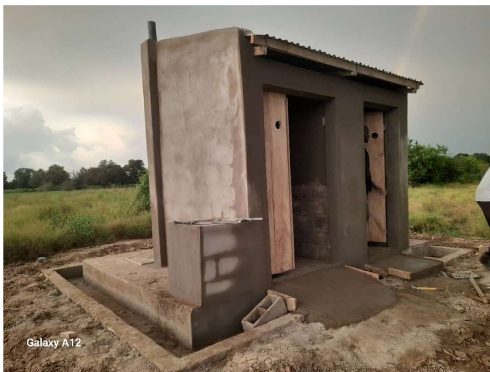
Photo 22: Latrines en cours de construction à Kabella et Bourgouma (Commune de Logone Birni)
