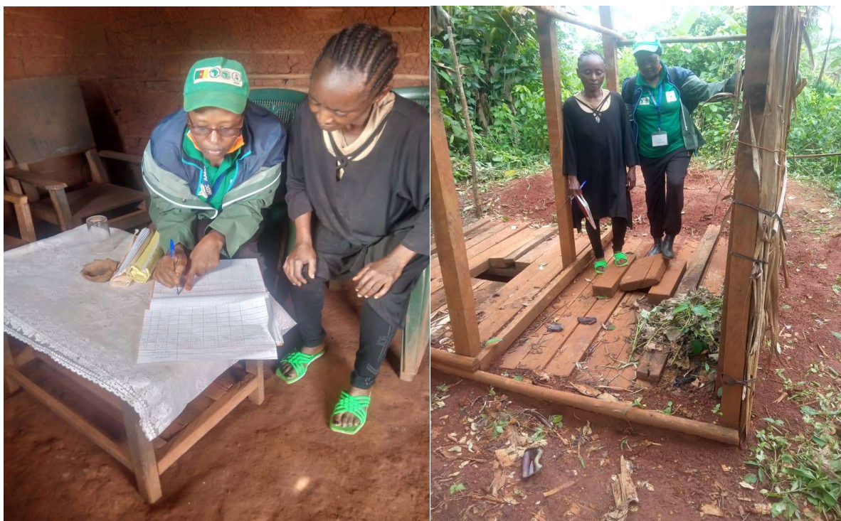
Photo 73 et 74 : Remplissage du cahier par la facilitatrice et suivi des constructions des latrines avec un CLS Plan dans la localité de NKouak (Commune d'Abong Mbang)
