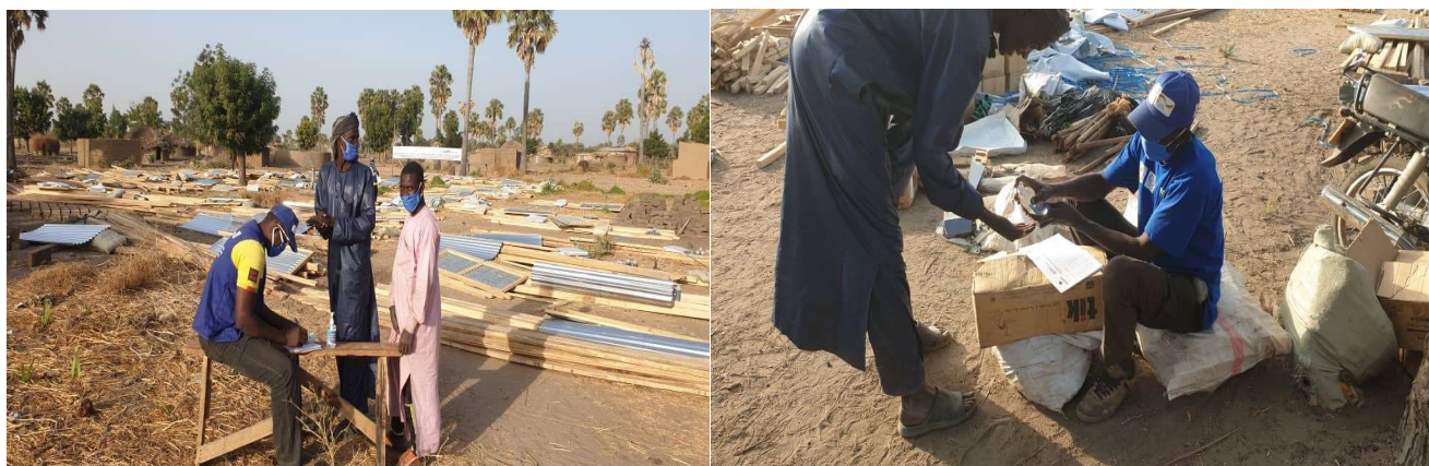
Photo N° 26 et 27 : Respect des mesures barrières par la désinfection des mains et le port du masque
