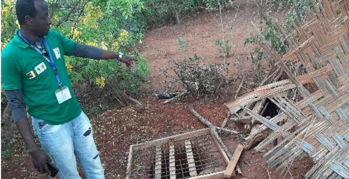
Photo 70 : Visite d'une latrine en cours de construction dans la localité de Mondial (Commune de Mayo Darlé)
